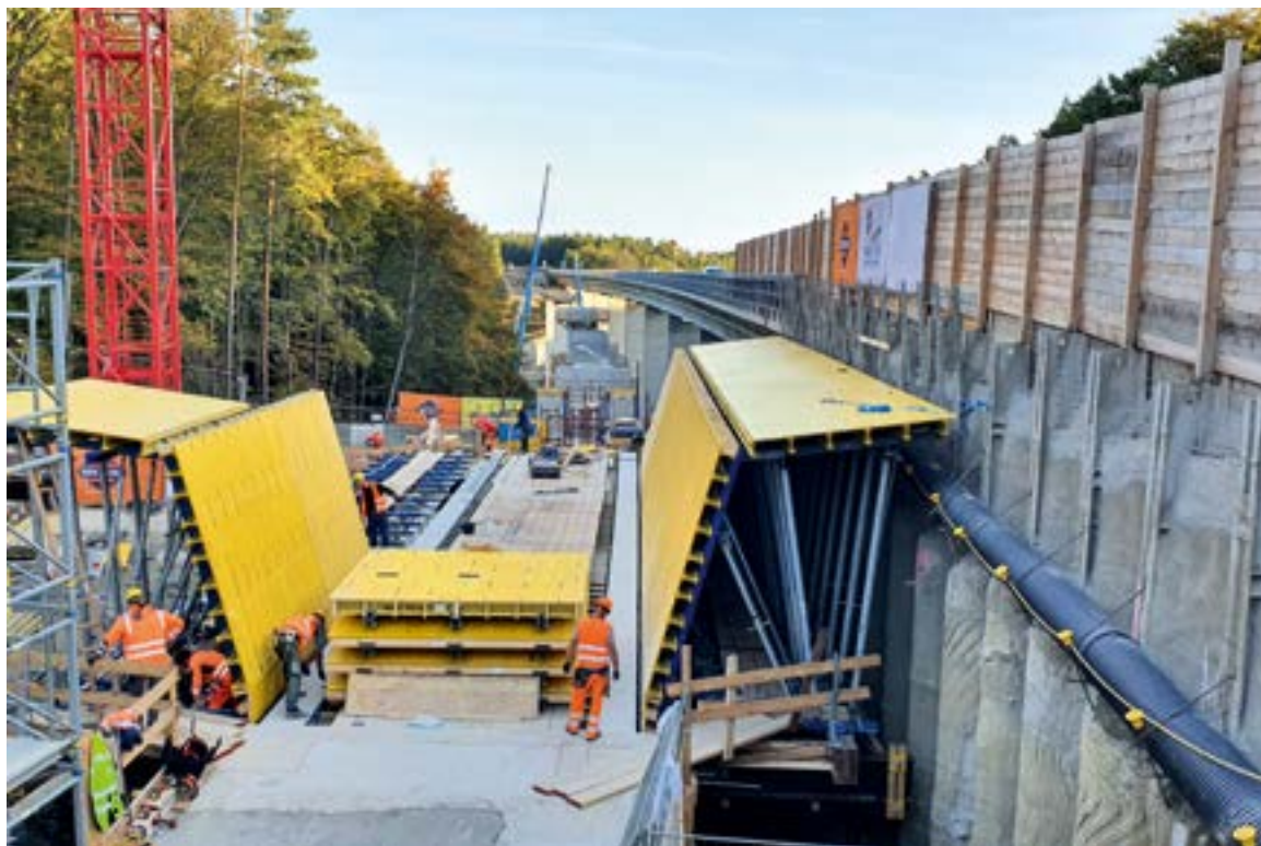
Tři ze čtyř mostů budou dokončeny metodou postupného výsuvu: betonové prvky se vyrábějí přímo na staveništi a vkládají se kus po kuse pomocí vysokotlakých lisů.
